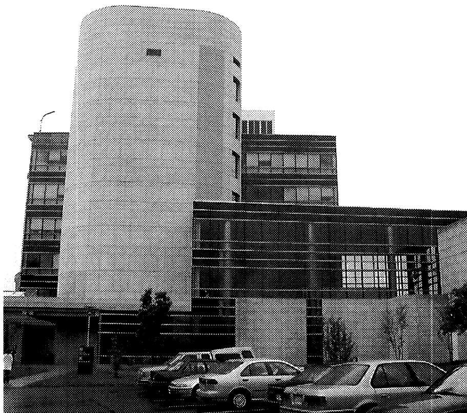
Fig. 4. 会議場であるNIH Natcher Building #45外観
